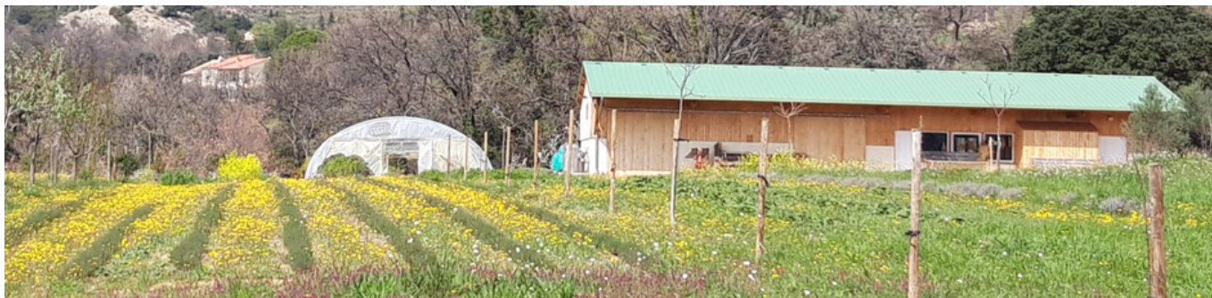
Bâtiment agricole 180m 2 , serre 80m 2 .
